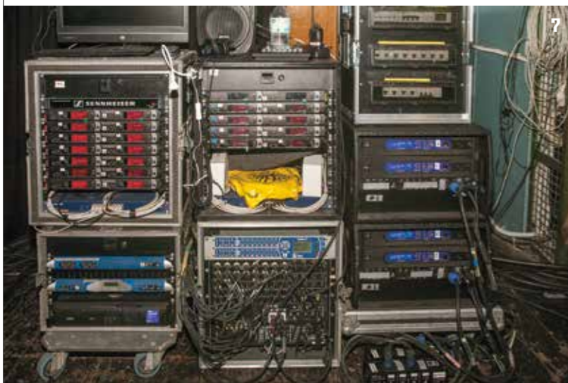
5_ L'impianto PA CODA, con 8+8 ViRAY laterali + 4 CODA TiRAY centrale.
