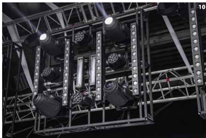
10_ Uno dei pod premontati del parco luci, che comprende 4 Robe Pointe, 4 Robe Robin 100 LEDBeam, 4 Highlite Sunstrip e 2 strobo Proel PLST15HDX.
