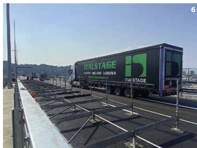
6_ Il primo tir sul nuovo ponte di Genova.
